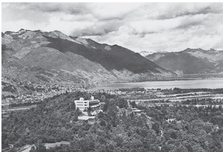
Diese Luftaufnahme zeigt den Monte Verità mit dem 1928 erstellten markanten Hotelneubau im Stil des Neuen Bauens. Die Umgebung dieses legendären Hügels oberhalb des Lago Maggiore hat Harald Szeemann als «Reformkulturlandschaft» bezeichnet.
