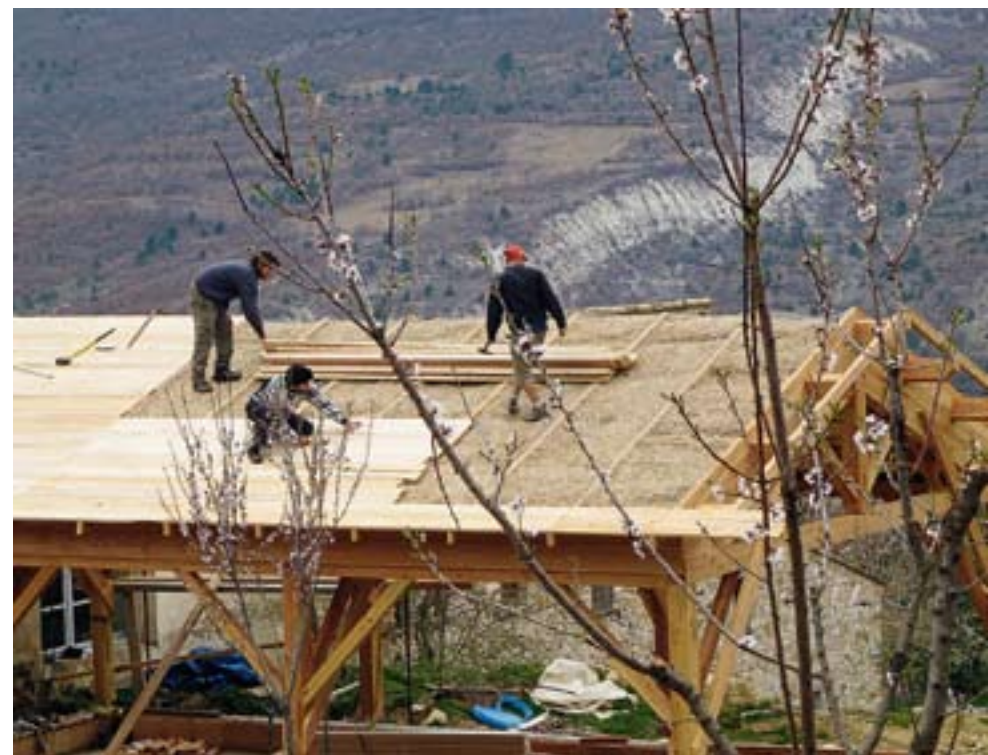
Links: Bau der Solar-Wassseraufbereitungsanlage in Grange Neuve
